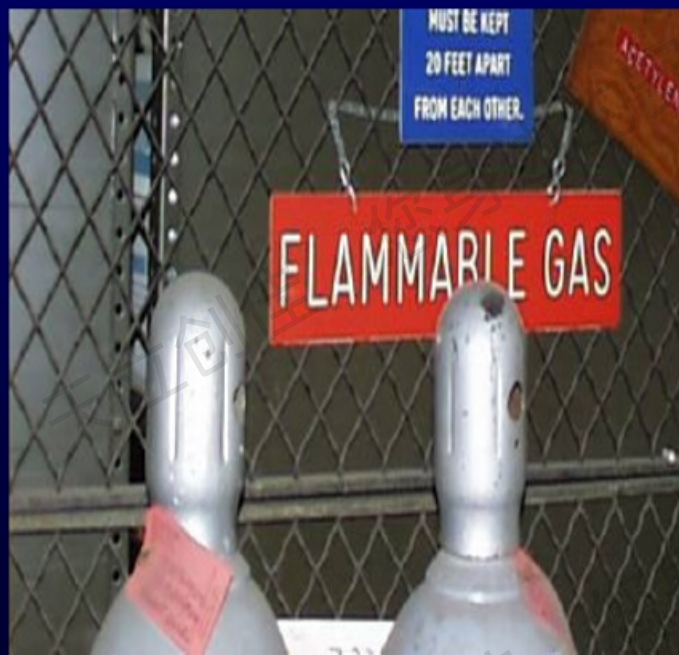
可燃钢瓶的正确隔离
